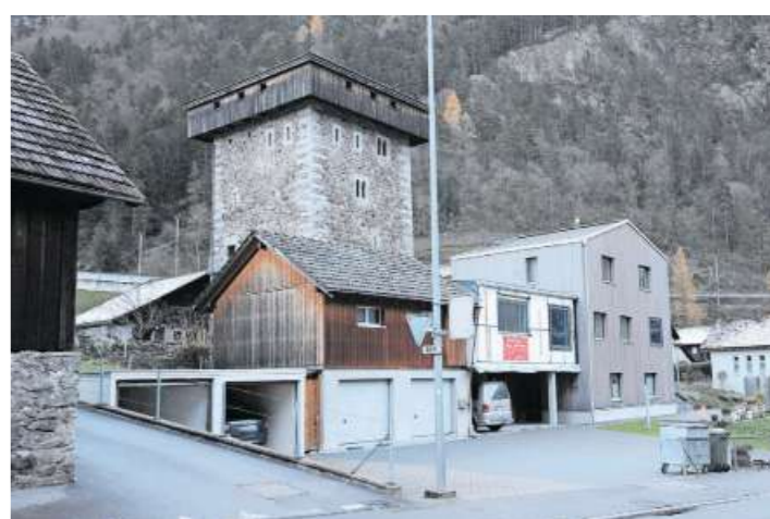
Für den Anbau zwischen den beiden Gebäuden wurde ein Baustopp verfügt.
