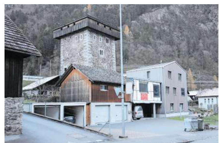
Für den Anbau zwischen den beiden Gebäuden wurde ein Baustopp verfügt.
