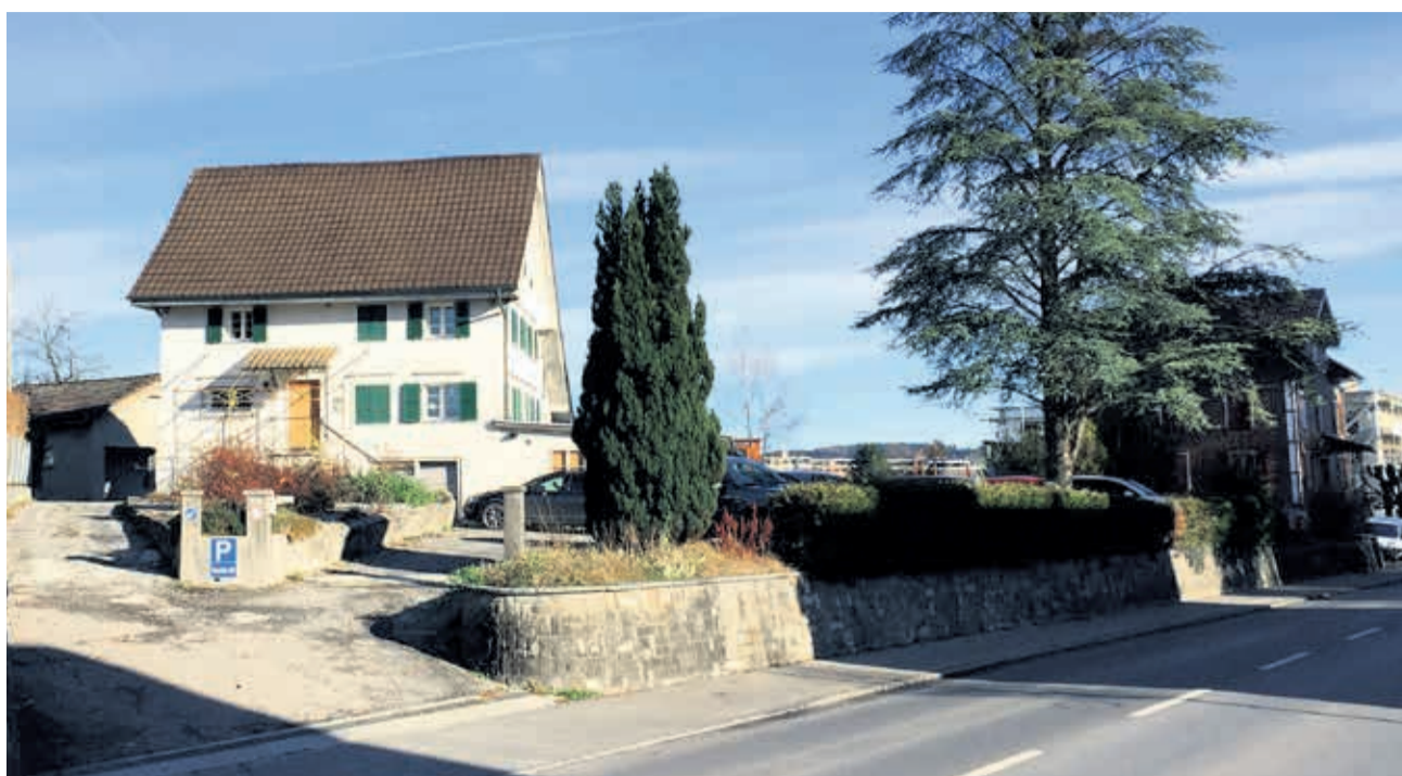
Hier entsteht das neue medizinische Zentrum. Das Mennel-Haus in unmittelbarer Nähe zum Haus Sonnmatt. Foto pd
